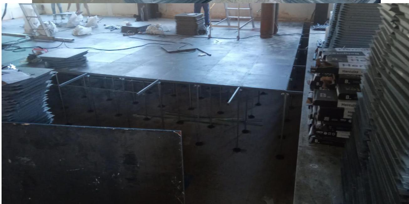
PISO VINÍLICO AUTOPORTANTE HERCULES 121,92 X 17,78 CM - ESPESSURA 5MM(INSTALADO)
