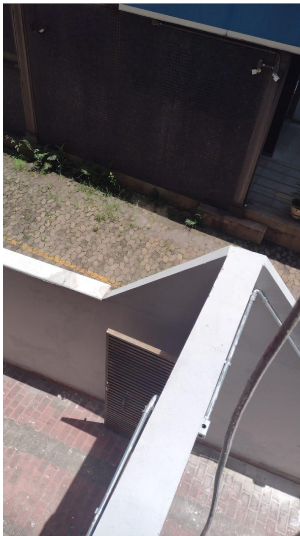
CORREDOR EXTERNO/SAÍDA EMERGÊNCIA – DIVISA COM INSS
