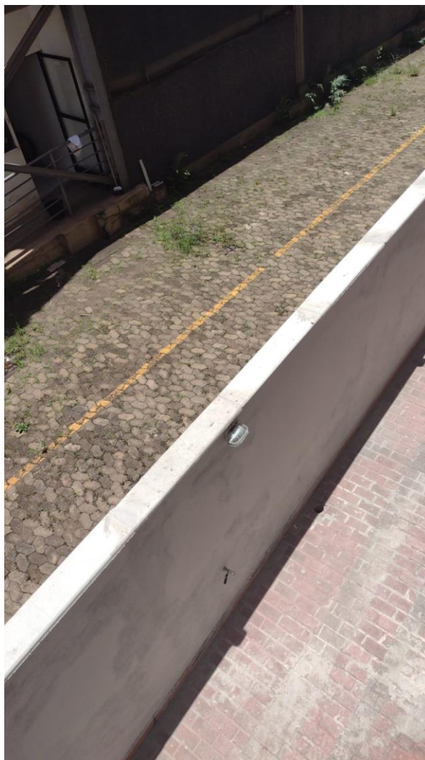
CORREDOR EXTERNO/SAÍDA EMERGÊNCIA – DIVISA COM INSS
