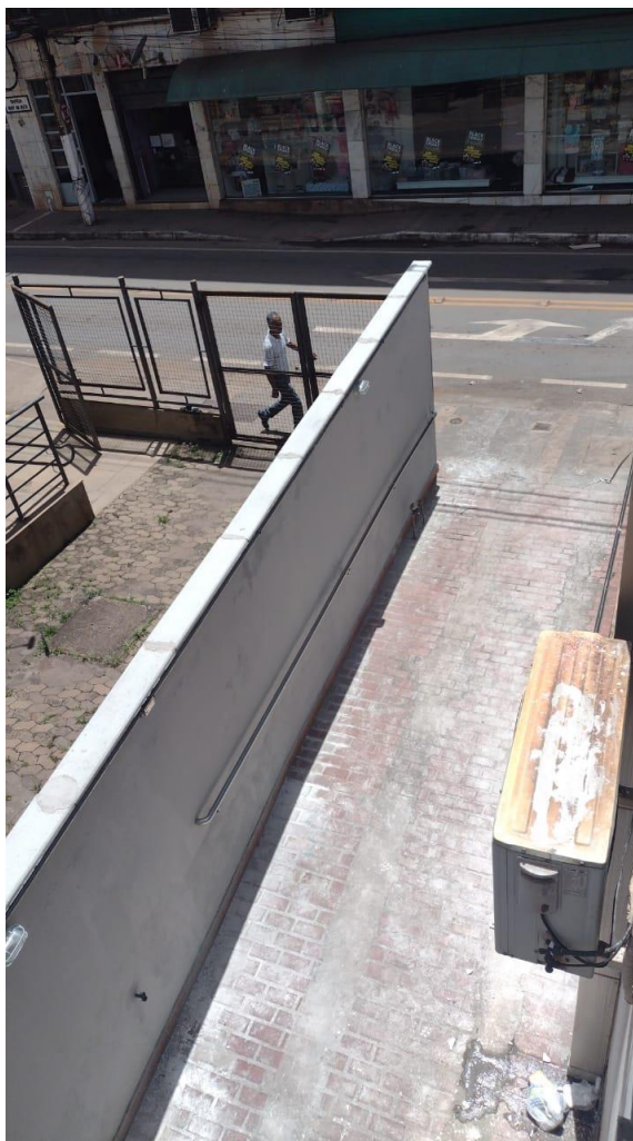
CORREDOR EXTERNO/SAÍDA EMERGÊNCIA – DIVISA COM INSS
