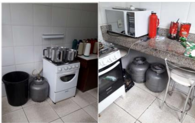
Item 43 – Armazenamento indevido de botijões de gás na cozinha, e sem qualquer tipo de sinalização de advertência ou alerta, resultando em área de risco para os colaboradores
