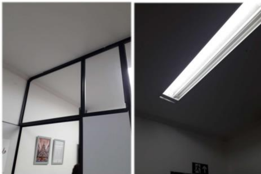
Item 48 – Desgaste na pintura da Sala do Vereador Robertinho, tomadas com desgaste por uso contínuo e falta de vidros das divisoras de ambiente
