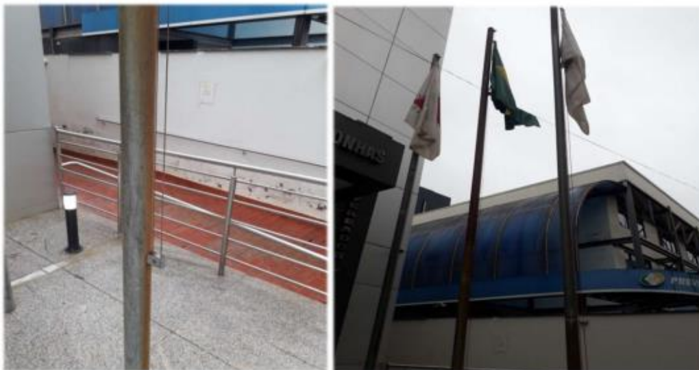
Item 02 – Cabos dos mastros localizados na entrada principal danificados por exposição ao tempo
