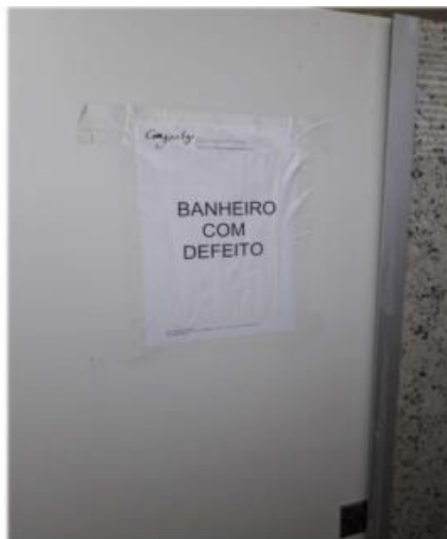
Item 66 – Janelas do banheiro feminino danificadas, torneira com defeito, vasos sanitários entupidos e porta de entrada com avarias.
