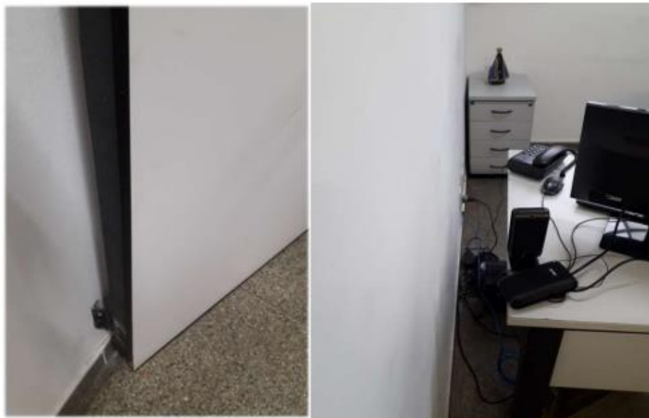
Item 56 – Amontoado dos cabos dos computadores na Sala do Vereador Lucas Bob, e porta da divisória emperrada
