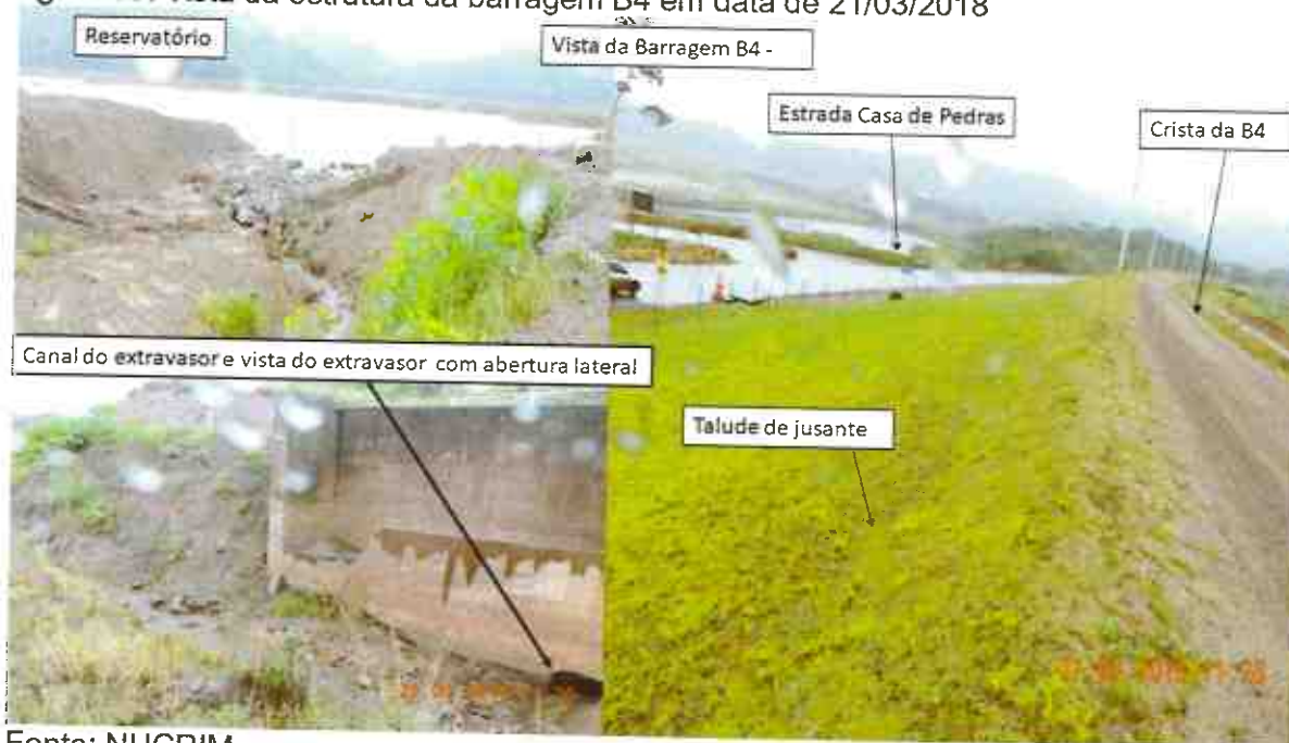
Figura 09: Vista da estrutura da barragem B4 em data de 21/03/2018
