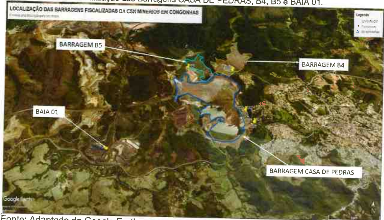
Figura 02: Vista da localização das Barragens CASA DE PEDRAS, B4, B5 e BAIA 01.
