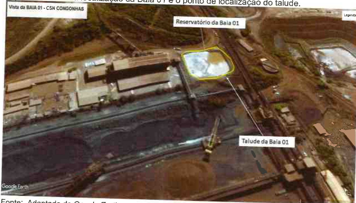
Figura 14: Vista da localização da Baía 01 e o ponto de localização do talude.
