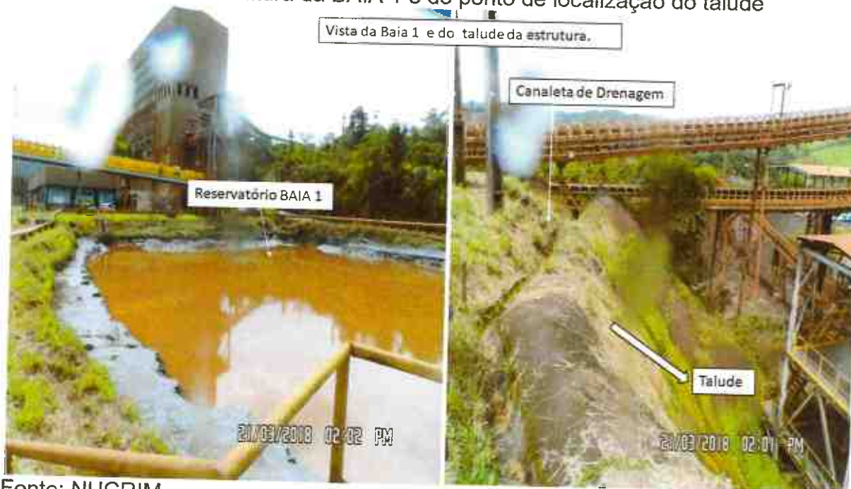
Figura 15: vista da estrutura da BAIA 1 e do ponto de localização do talude
