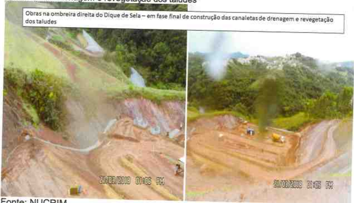
Figura 13: Obras na ombreira direita do Dique de Sela em fase final de construção de canaletas de drenagem e revegetação dos taludes
