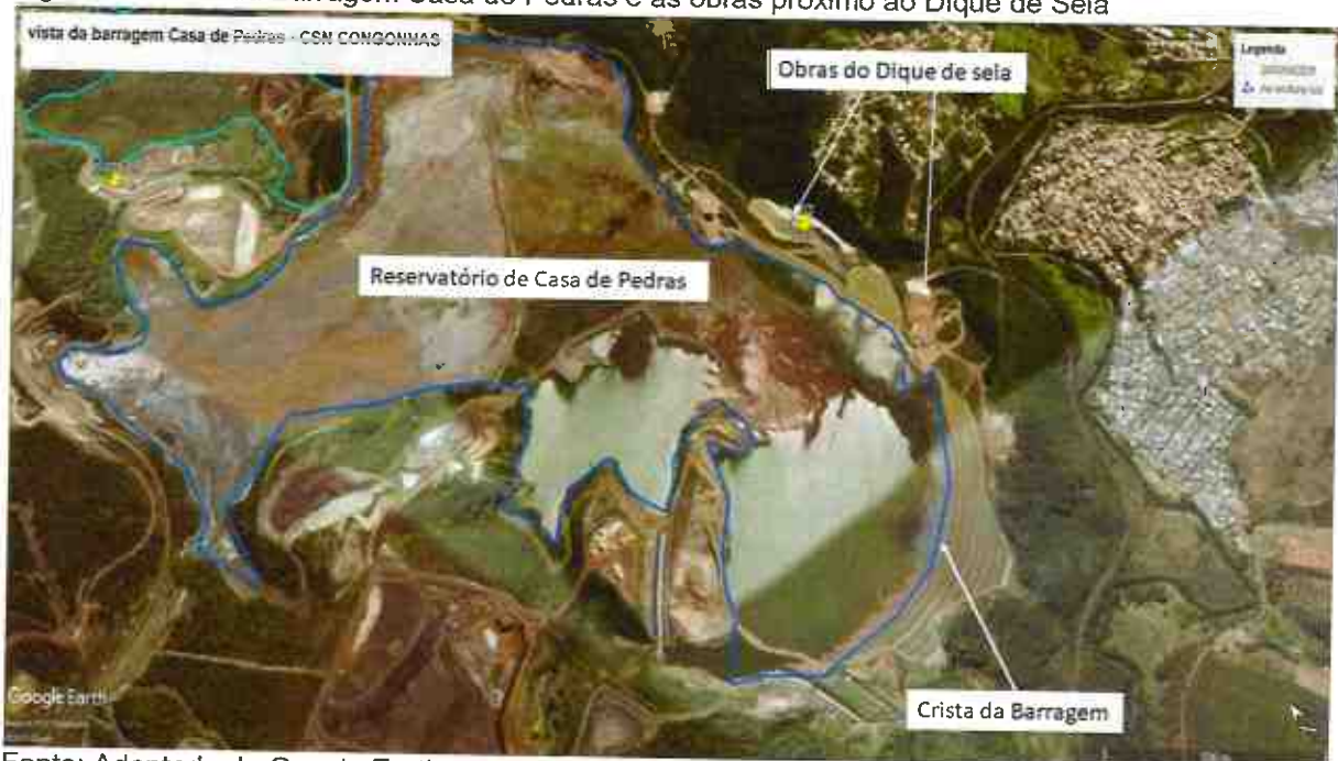
Figura 10: Vista da Barragem Casa de Pedras e as obras próximo ao Dique de Sela
