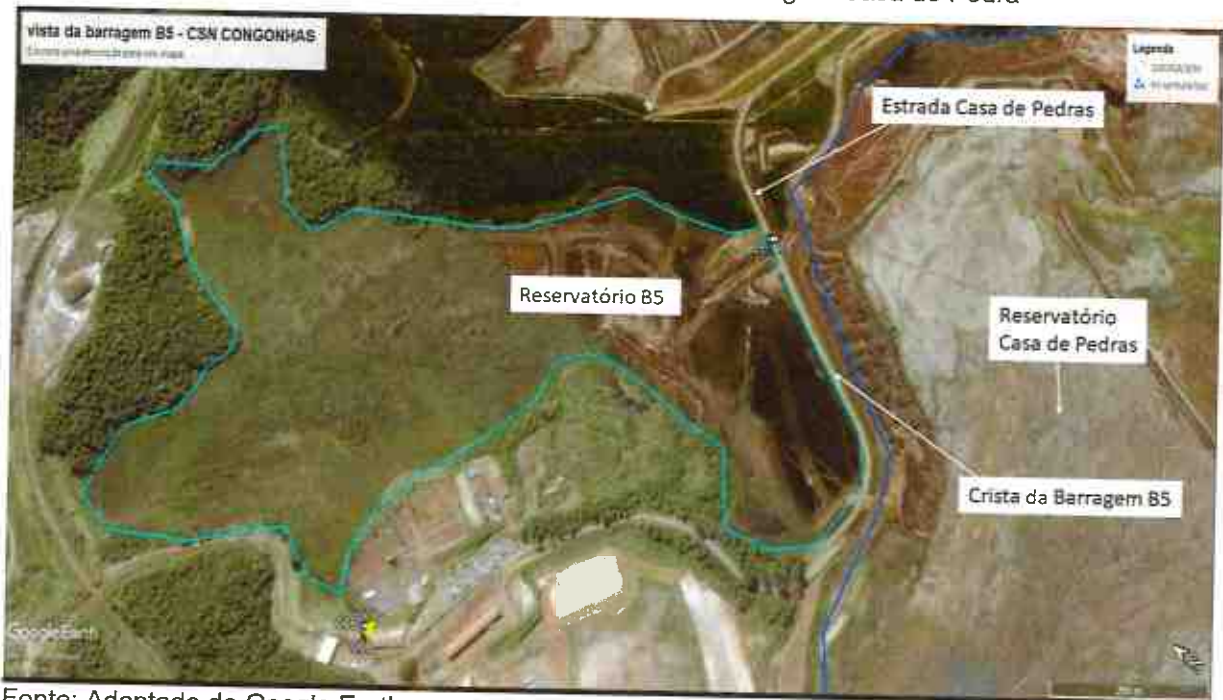
Figura 04: Vista da Barragem B5 localizada à montante da Barragem Casa de Pedra
