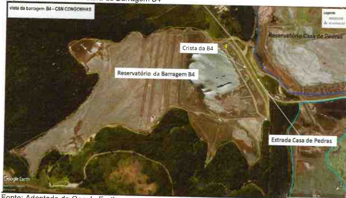
Figura 07: Vista da estrutura da Barragem B4
