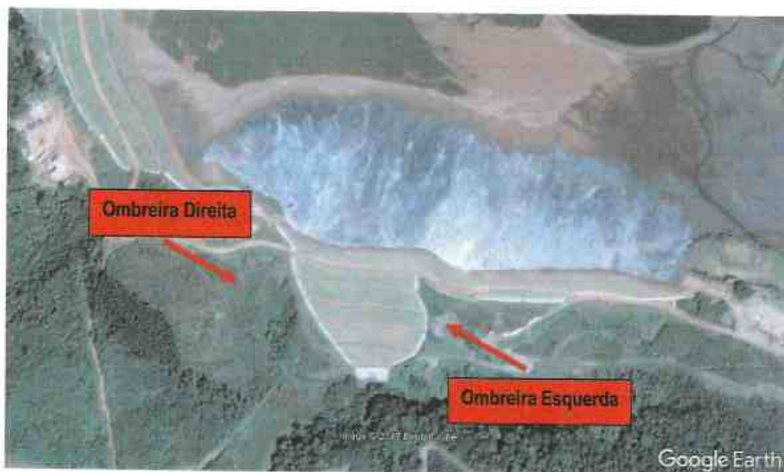
Figura 3: Imagem aérea com vista frontal do dique da sela realçando de vermelho as ombreiras onde estão sendo executadas as obras de manutenção/ emergência (Fonte: GoogleEarth)
