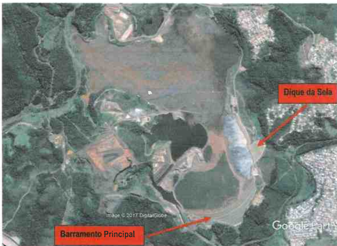
Figura 1: Imagem aérea da Barragem Casa de Pedra (BCP). De vermelho estão realçados os barramentos principal e da sela (Fonte: GoogleEarth)
