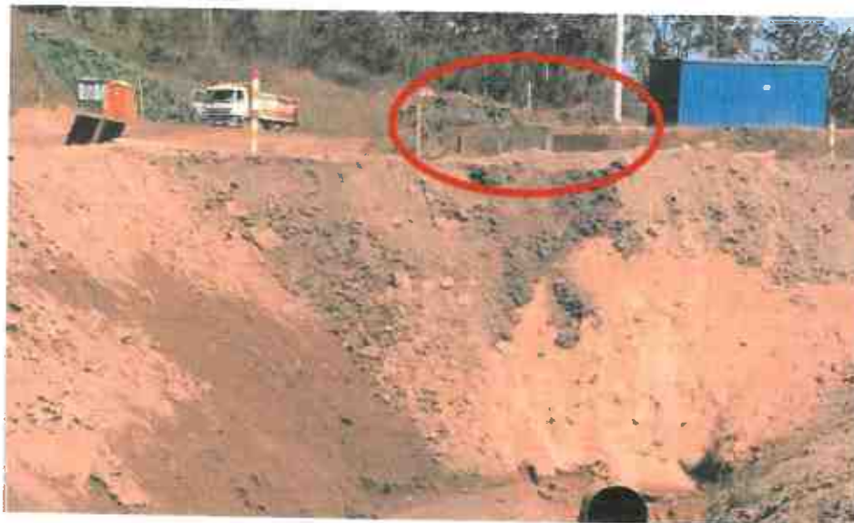
Figura 10: Vista do aterro implantado, interceptando o extravasor da Barragem B4 (a parte superior das paredes do extravasor estão realçadas pelo círculo vermelho)
