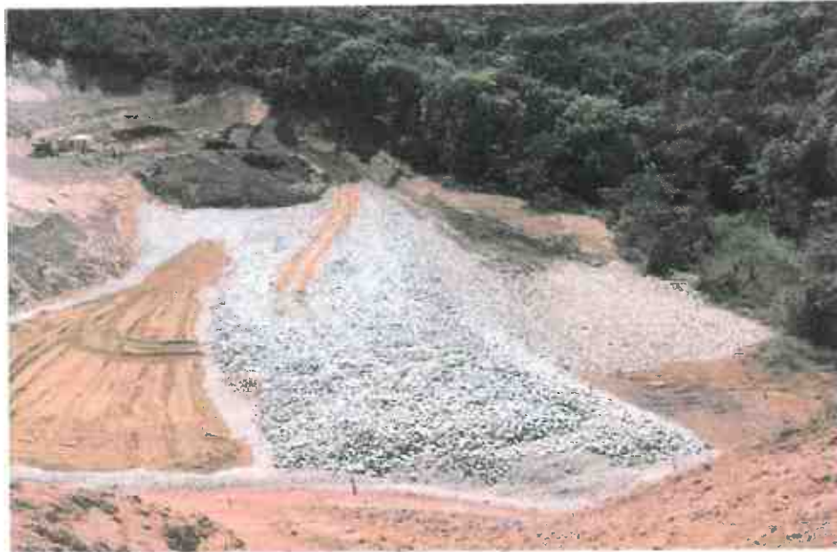
Figura 4: Vista frontal da obra na ombreira esquerda do dique de sela
