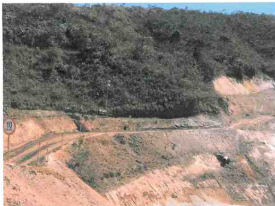
Figura 5: Vista da parte superior da ombreira esquerda (acima do local da obra), onde é possível observar o solo ainda bastante úmido
