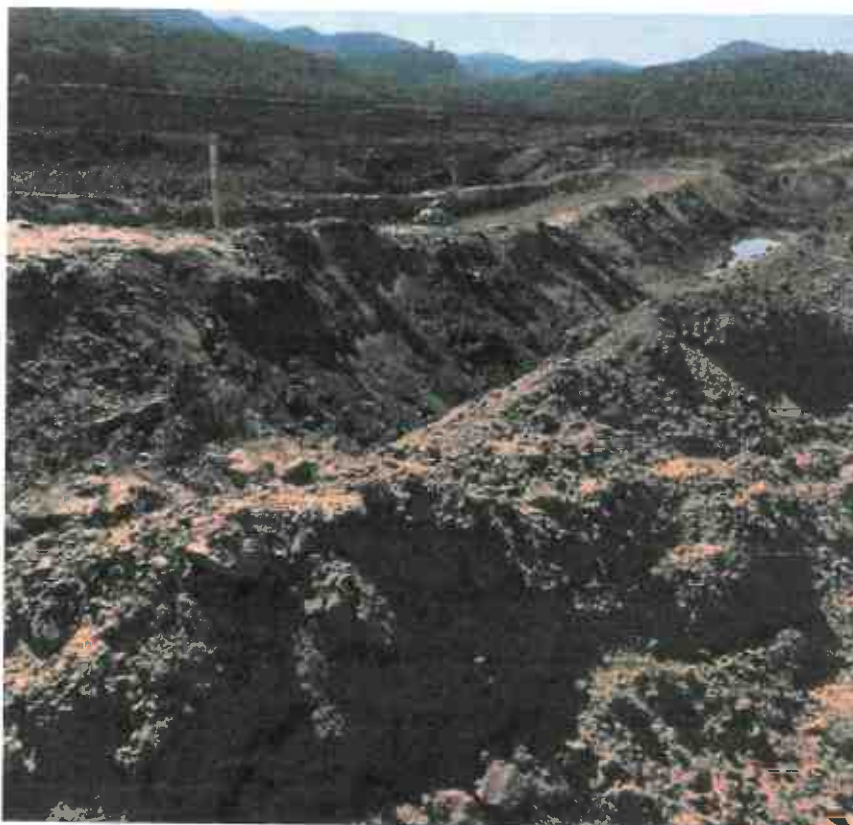
Figura 9: Vista do reservatório da Barragem B4, onde está sendo remanejado o rejeito
