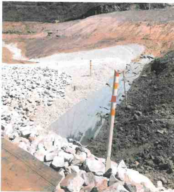
Figura 6: Detalhe do tipo de obra em execução (implantação de filtro invertido)
