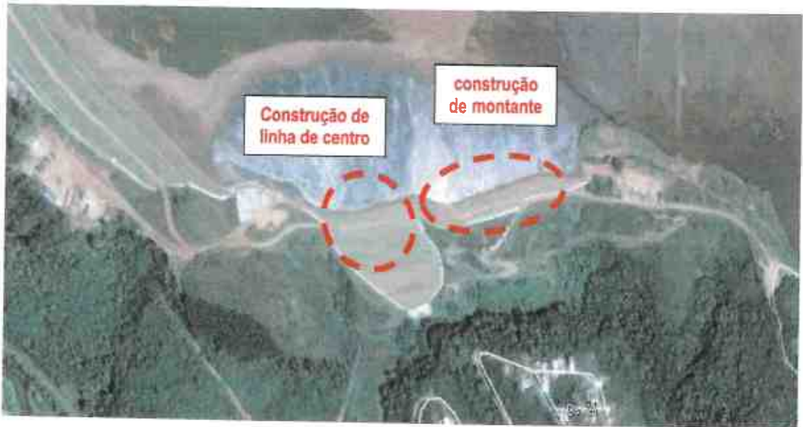
Figura 13: Imagem com vista frontal do Dique da Sela distinguindo os locais aproximados onde o barramento foi construído pelos dois métodos
