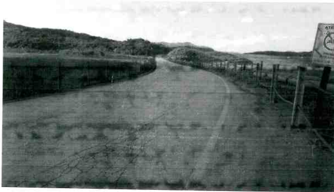
Figura 13: Vista da crista da Barragem B5 Fonte: Laudo de Auditoria, 2013
