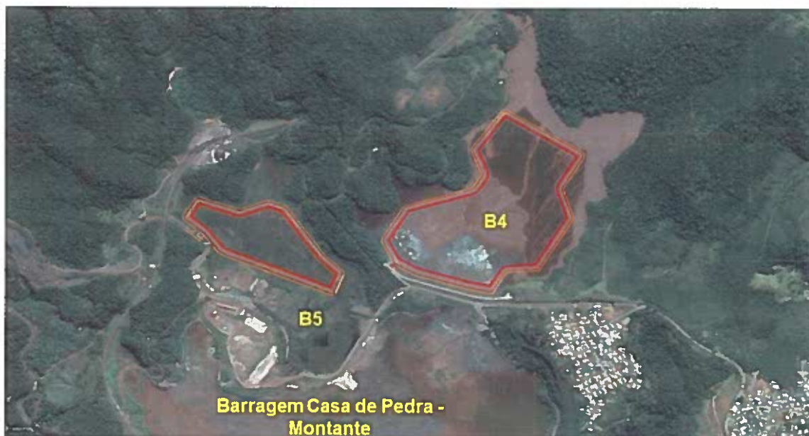
Figura 4: Locais de remoção dos rejeitos
