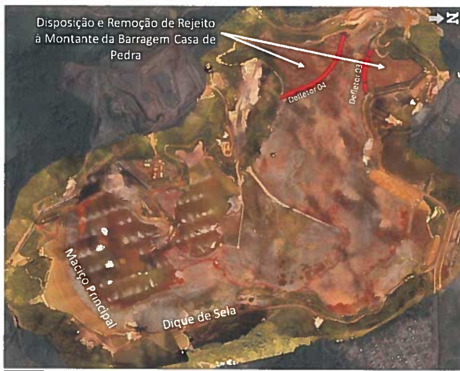
Figura 5: Locais de remoção e disposição dos rejeitos
