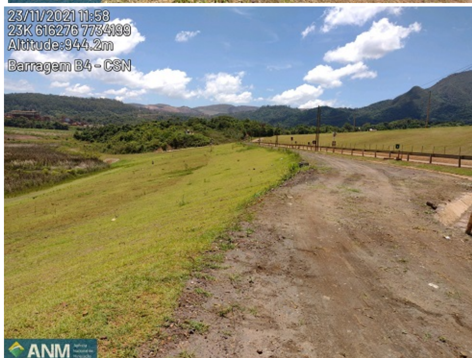
Foto 1 - Vista do talude de montante e da borda livre do reservatório. executado no talude de jusante.
